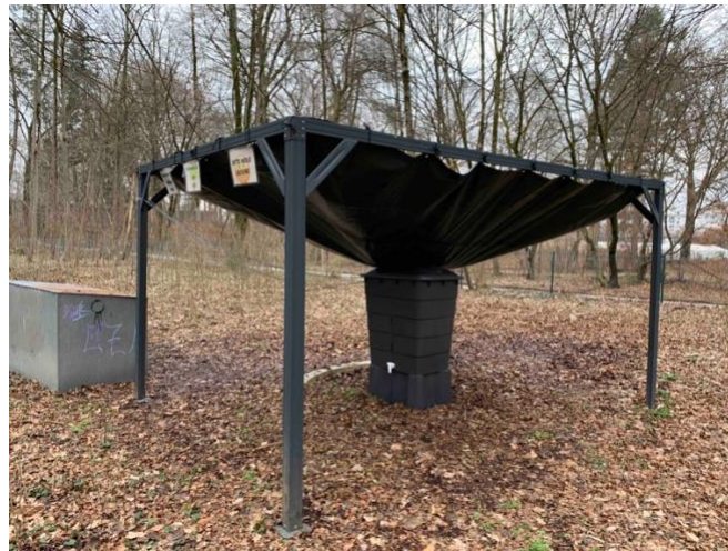
Abb. 4: Unsere fertige Regenwassersammelanlage
