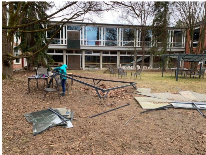
Abb.2: Mit Akkuschrauber und manchmal mit der Brechstange: ein Pavillon wird zerlegt.
